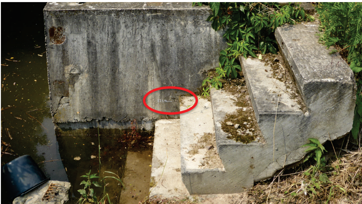
Abbildung 10.1: Fragwürdige Markierung des angeblichen Höchstwasserstands am 27.5.2014 bei Lotzebach-km ca. 3+200 nur 1,5 Treppenstufen über dem Normalwasserstand
